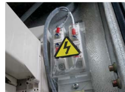
ลักษณะการติดตั้งแบบ Base Mounting ที่มีการระบายความร้อนสู่แผ่นโลหะ
