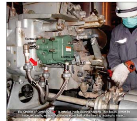
รูปภาพที่ 2 แสดงตำแหน่งการติดตั้ง Governor และท่อน้ำมันที่เกี่ยวข้อง
