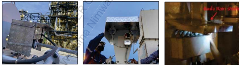
รูปที่ 5 ตัวอย่างการติดตั้งหลังคาสำหรับ instrument terminal box
