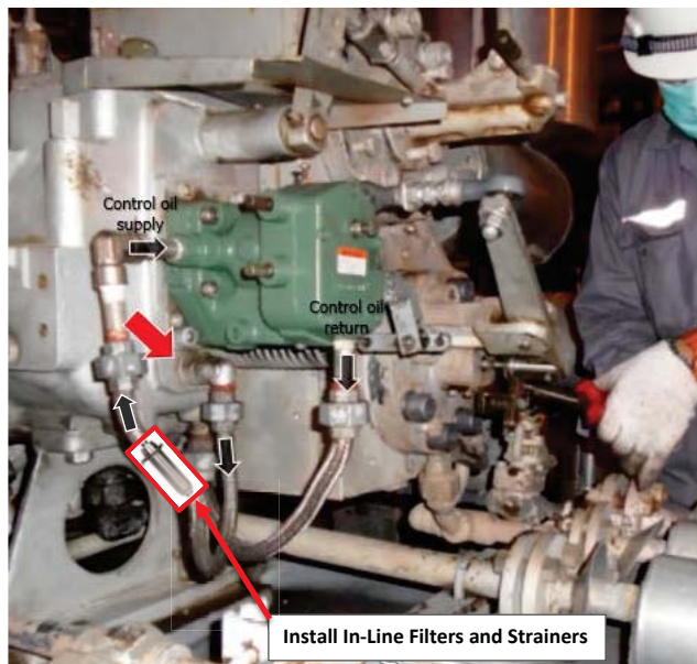
รูปภาพที่ 6 แสดงตัวอย่างตำแหน่งที่แนะนำในการติดตั้ง In-Line strainer
