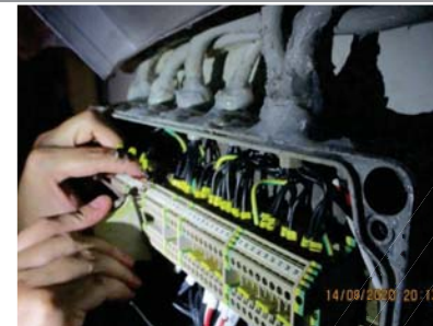
รูปที่ 3 LDPE terminal box ที่มีความชื้นเข้า
